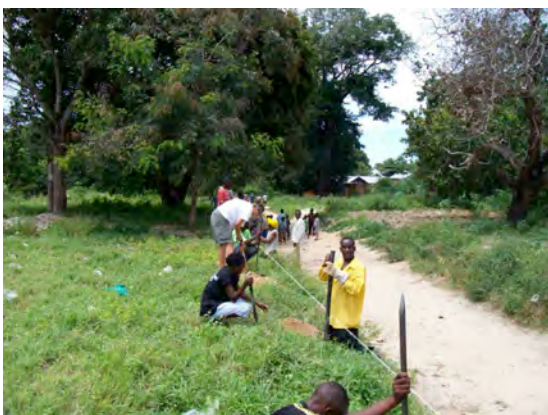
Die Löcher für die Zaunpfähle bringen alle zum Schwitzen
