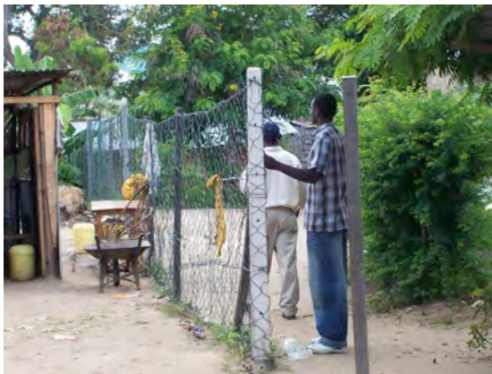
Der Zaun wird auch durch das besetzte Gelände gebaut!
