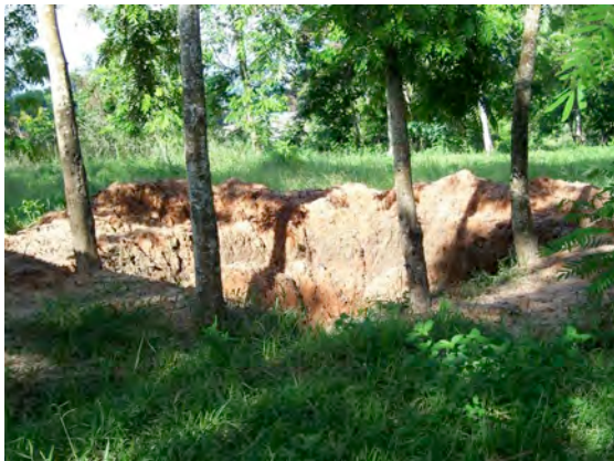
Hier entsteht der Regenwasserspeicher
