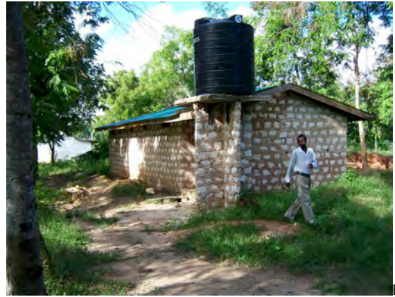
Das Dach, Außenwände und Innenausstattung sind noch in Arbeit
