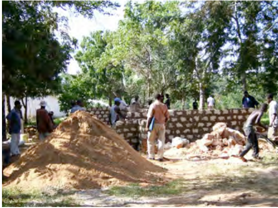
Sanitärgebäude mit Wasserspeicher im Bau.
