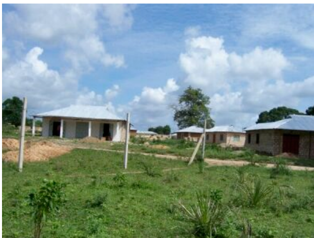
Neue Häuser rings herum um das geplante Gemeindezentrum, ...
