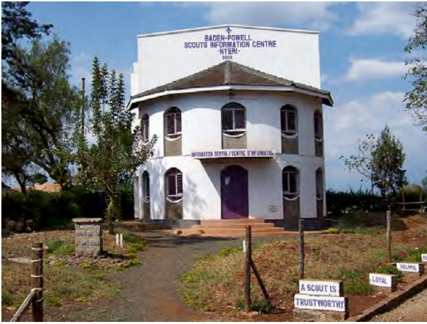
Infozentrum am Eingang
